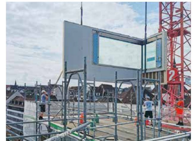
Abb. unten_ Montage der eckverglasten Fassadenelemente.
