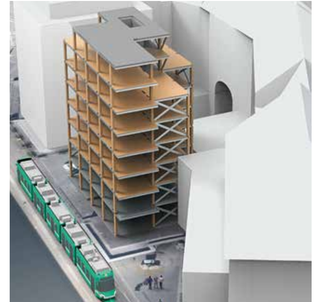
Abb. oben_ Modell und Konstruktionsprinzip des achtstöckigen Büroneubaus.
