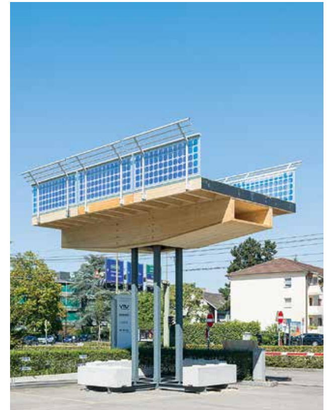
Abb. links _Die 20 Meter langen Elemente ermöglichen einen freien Verkehrsfluss auf zwei Rädern in der Höhe.
